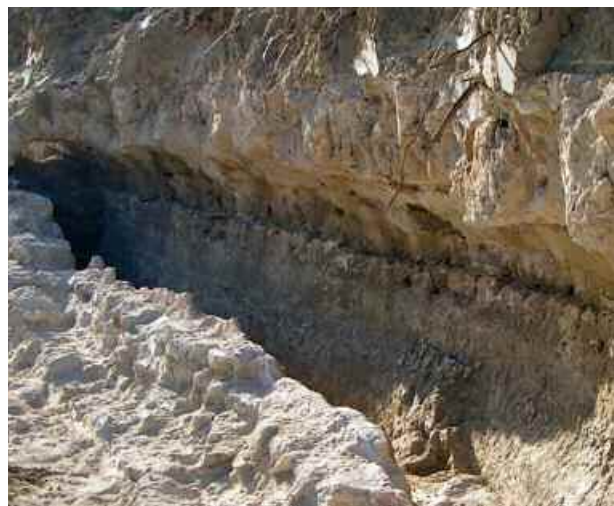
Vestiges de l'aqueduc découverts en aval du Pont Rouge
